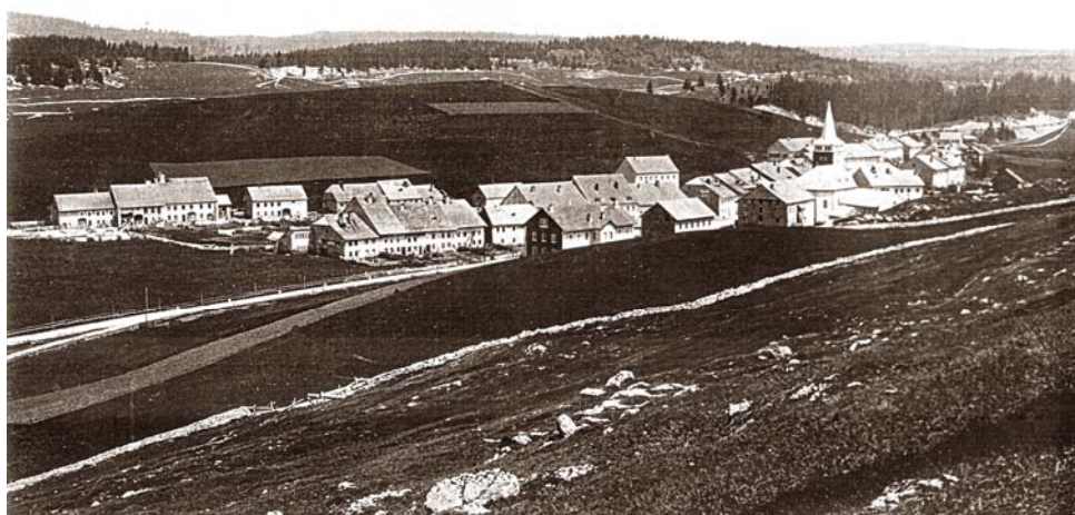
Le Lieu, en 1886, soit quelque quinze ans après le passage des Bourbakis. Il restait sensiblement pareil à ce qu'il était depuis le début des années soixante, presque entièrement reconstruit à la suite de l'incendie de 1858 qui en avait ravagé à peu près les 2/3.
