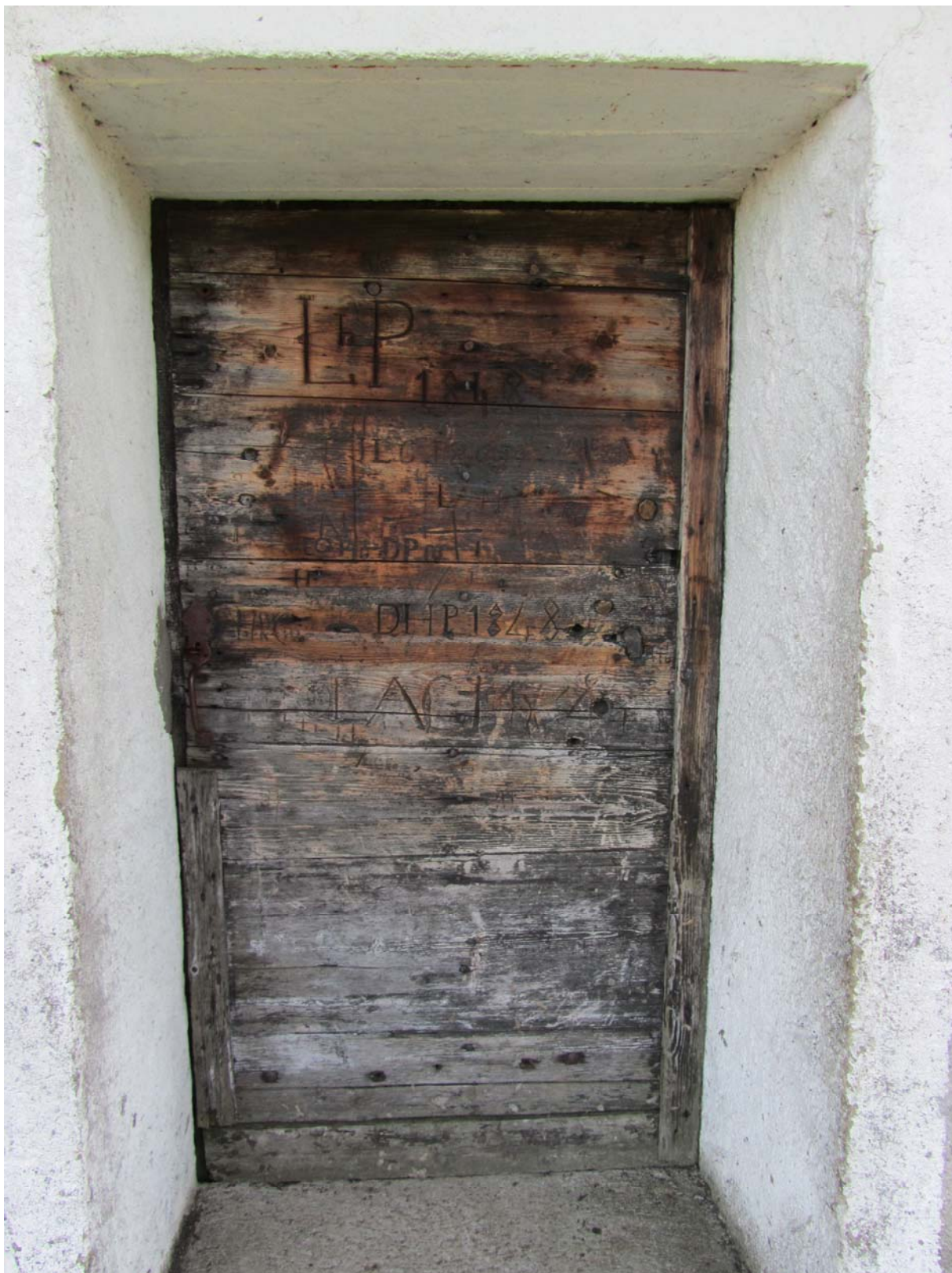
Porte arrière du Chalet à Roch-Dessus.
