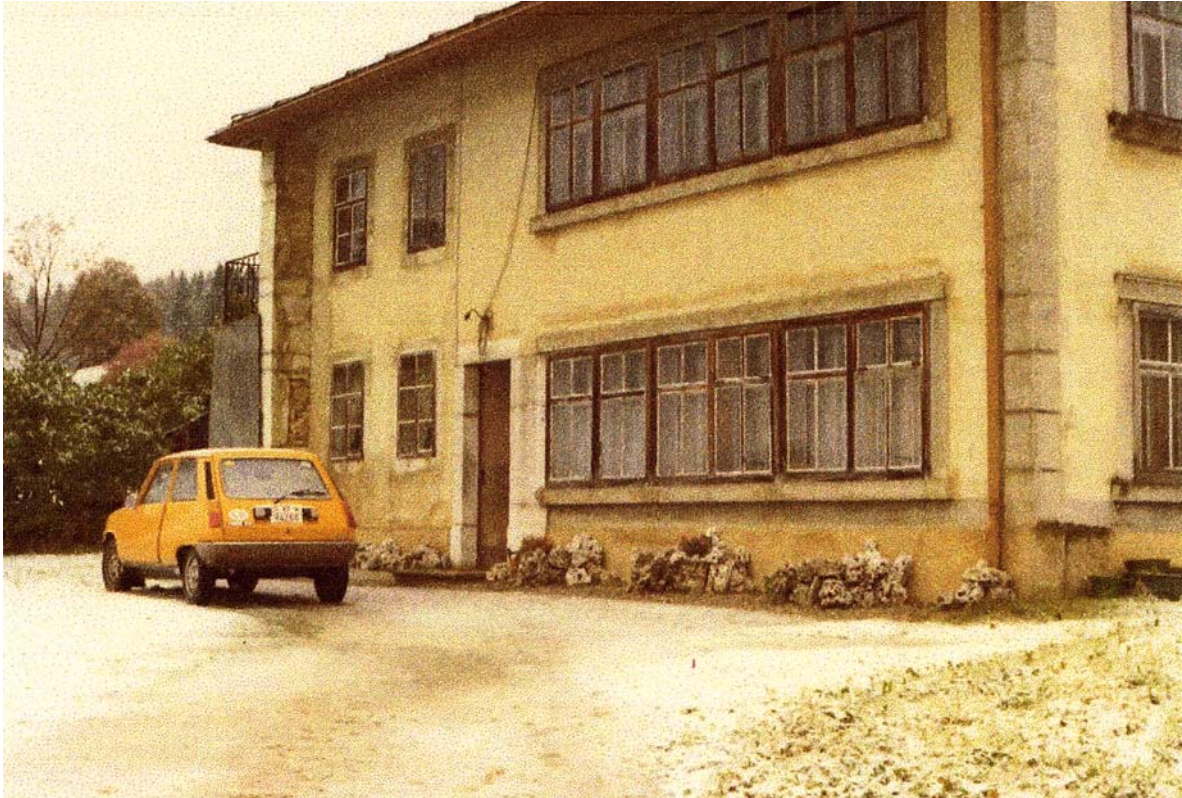
Atelier Aubert en 1981, lors du démantèlement.
