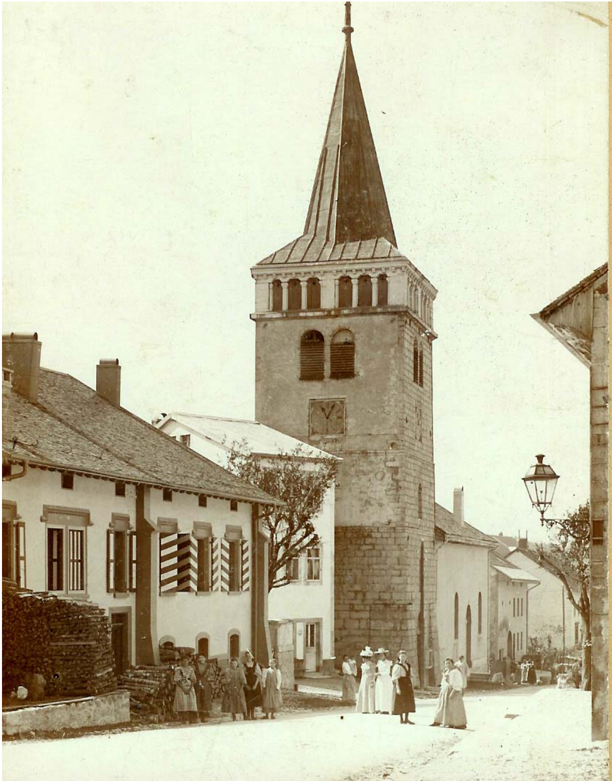
L'église affublée de la maison Lecoultre dès la fin du XIXe siècle et jusqu'en 1955 où elle fut démolie.
