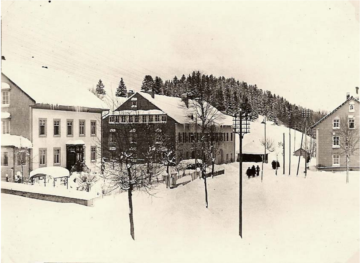
Au centre, la maison d'Ulysse Le Coultre. Les fenêtres de l'atelier de fabrication des pignons est au second étage.
