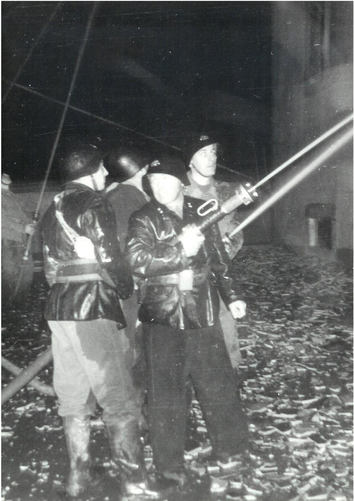
Les pompiers à l'œuvre à l'arrière du bâtiment. Y a plus rien à faire.
