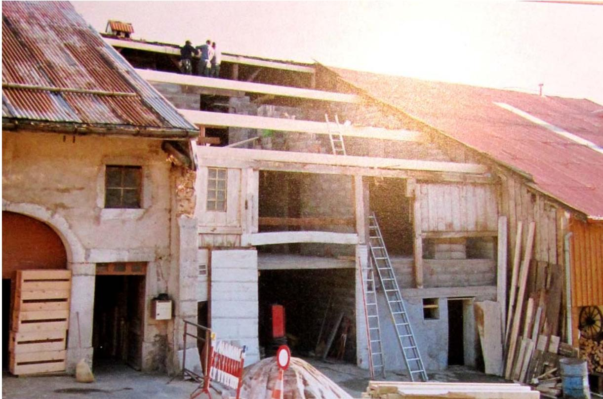
Début des travaux de réfection du toit. On a enlevé la couverture en tôle, la sous-couverture en tavillons et en lambris et puis la poutraison. Les poutres maintenant sont flambant neuves sur lesquelles on met en place les chevrons, opérations à voir ci-dessous.
