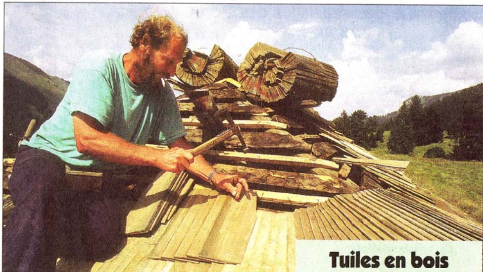
Au-dessus d'Olivier Veuve, les «bosses», sortes de fagots, contenant des tavillons pour recouvrir environ un mètre carré de toiture. Andrée-Noëlle Pot
