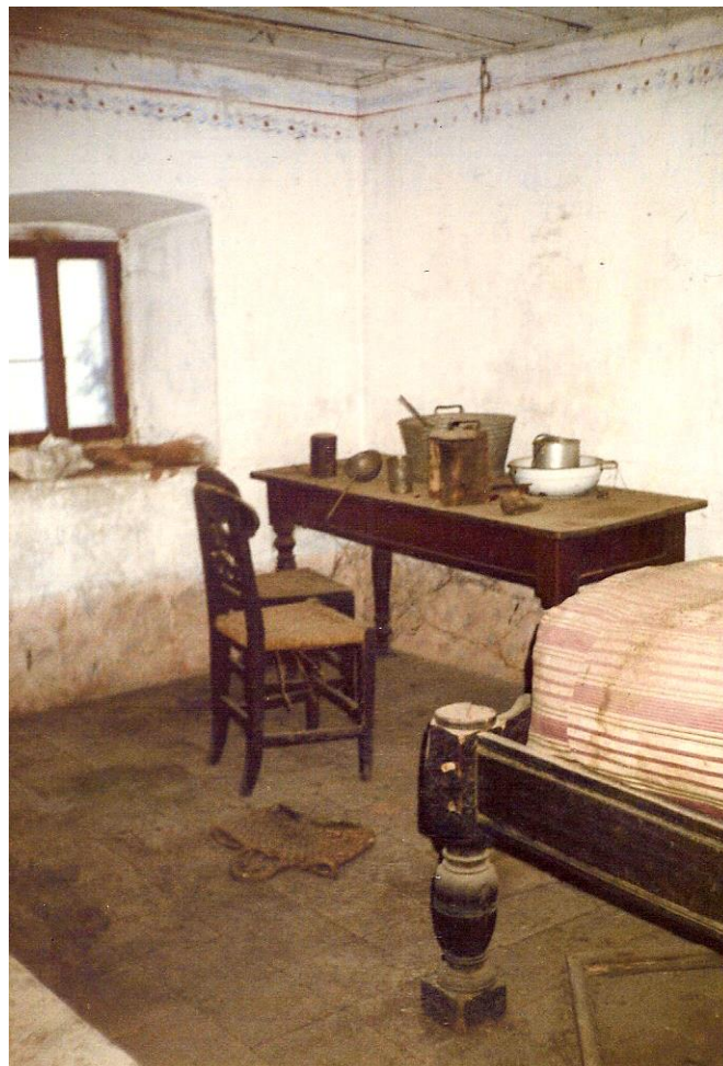
L'une des rares photos à disposition concernant l'intérieur d'une maison. Chambre bâtiment Pelac en 1985. De l'authentique, la table, les chaises paillées et le lit, avec un matelas énorme rempli de feuille de maïs.
