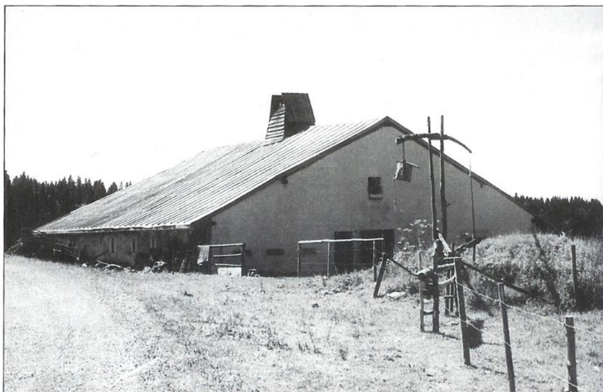
La Vieille Landoz est un exemple des typiques chalets d'alpage du Risoud. Les volets ou vantaux de la cheminée s'ouvrent ou se ferment de l'intérieur. Au premier plan, on remarque le balancier qui sert à puiser l'eau dans la citerne.
