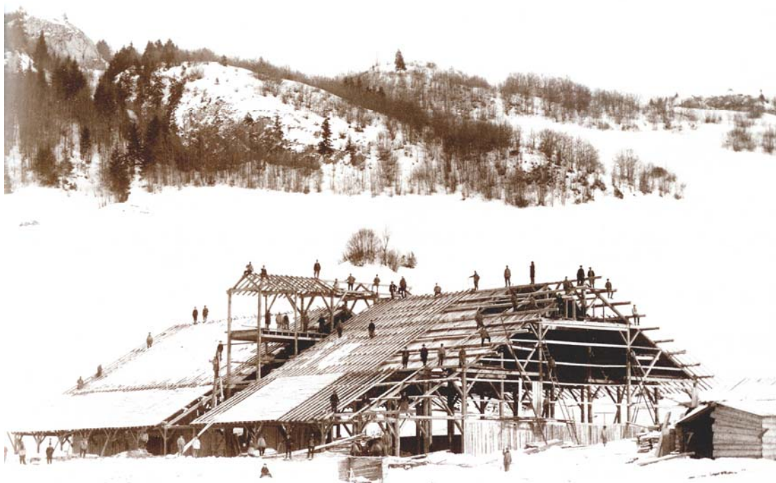
Construction des glacières à la fin de 1879 ou au début de 1880.
