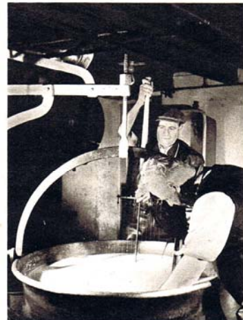
6 La masse blanche est brassée avec un instrument composé de fils de fer tendus sur un cadre.
