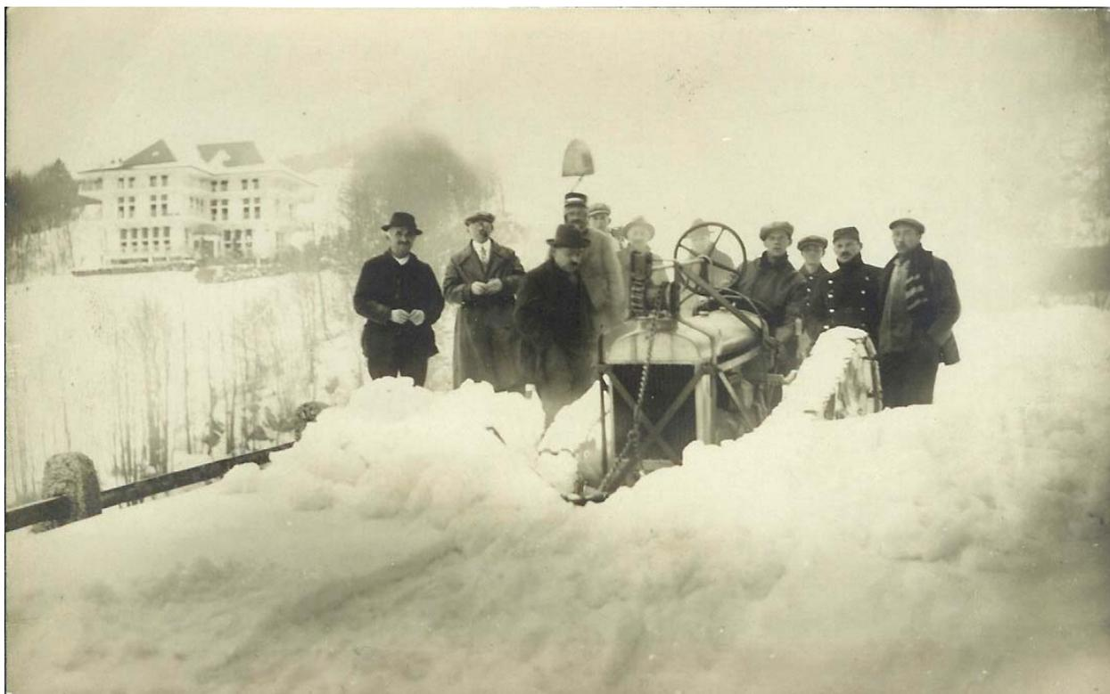
Et voilà l'engin. L'un des rares tracteurs de l'époque muni d'un triangle frontal. L'épaisseur des neiges ne permet pas toujours un travail optimal. Les cantonniers accompagnent le tracteur qui doit être bloqué plus souvent qu'à son tour. A droite, la Bunau-Varilla. Nous sommes dans les années vingt.
