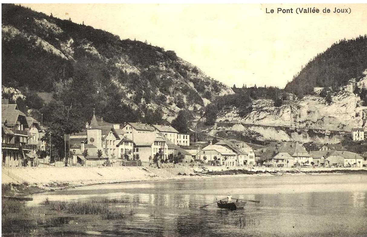
Et déjà l'état final sur la plupart des cartes postales. Les travaux ont donc été rondement menés.
