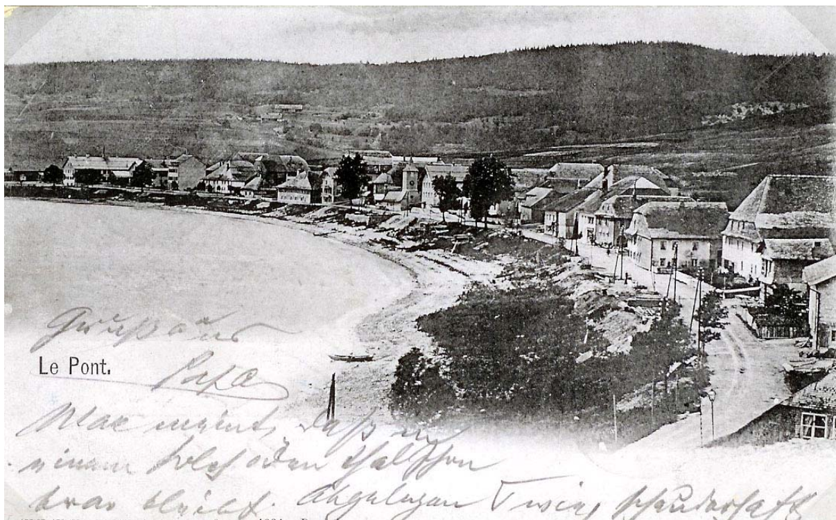
En apparence travaux en cours.
