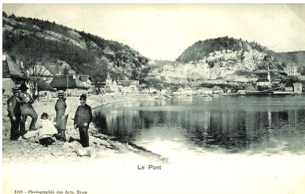
Faudrait-il voir les travaux d'empierrement en cours sur ce cliché ?
