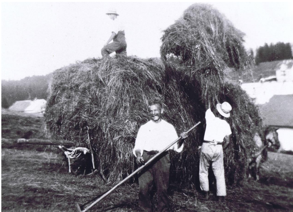
On charge à la Chaux au Lieu.
