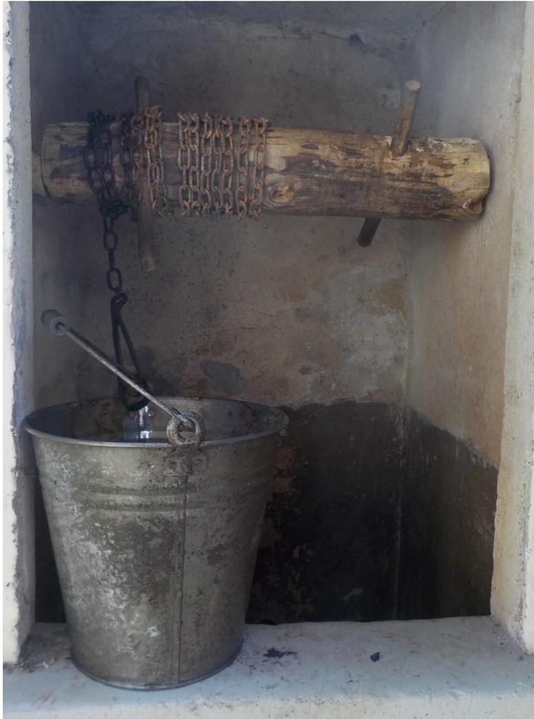
Le treuil est de fabrication récente. L'attache métallique pour joindre le seau à la chaîne est d'origine.
