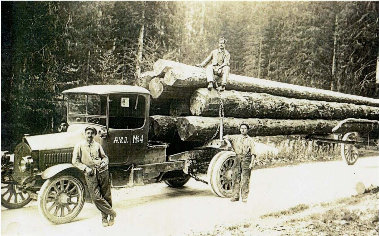
La compagnie AVJ est la première probablement à s'être équipée à la Vallée pour les chargements des longs bois. Les quantités apparaissent aussitôt plus impressionnantes que sur les attelages encore tirés par les chevaux.
