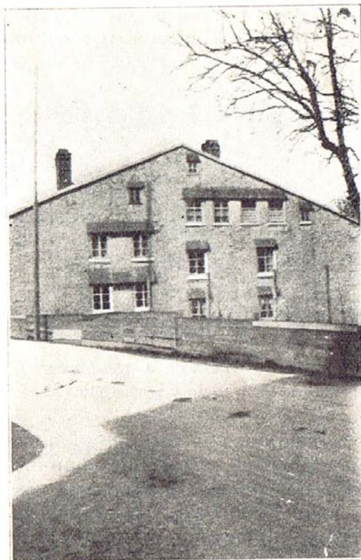
FIG. 20. — CHEZ-LE-MAITRE. Pignon Sud-Ouest d'une maison double. Auvents et revêtement en tavillons.
