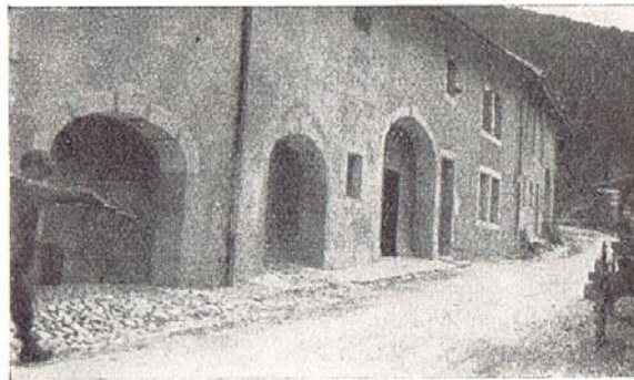
FIG. 21. — UNE RUE A L'ABBAYE. Granges et écuries aux portes cintrées.
