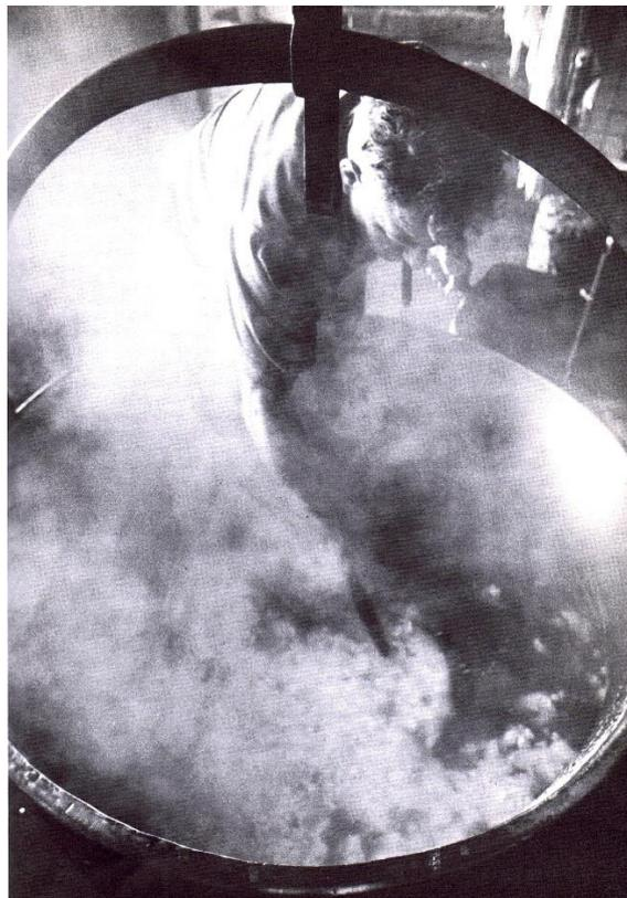
La fabrication du séré à partir du petit-lait porté à haute température. On voit les « dames » montées à la surface et que l'on va bientôt récolter avec la poche à séré en cuivre. PH p. 178.
