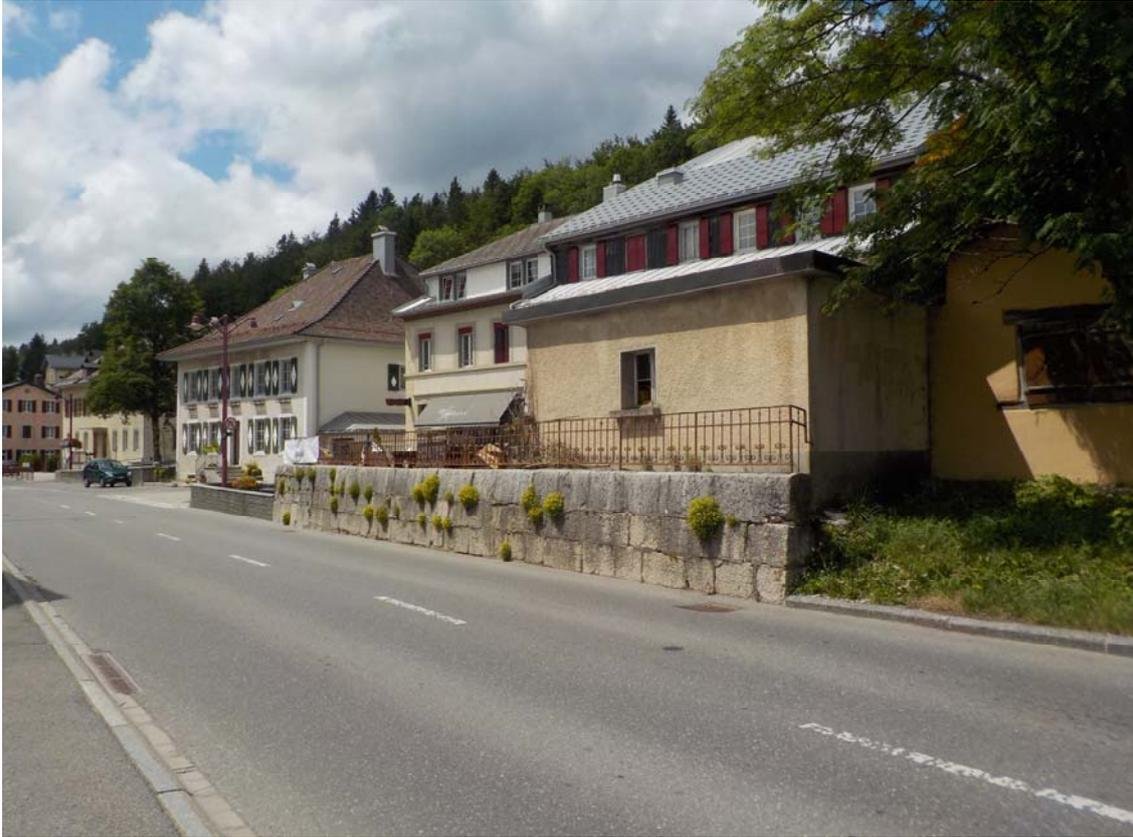
Nouvelle route avec mur de soutien des bâtiments du Haut-du-Sentier qu'il convenait de sécuriser avec le creusement du terrain pour donner moins de dénivelé à cette nouvelle artère.
