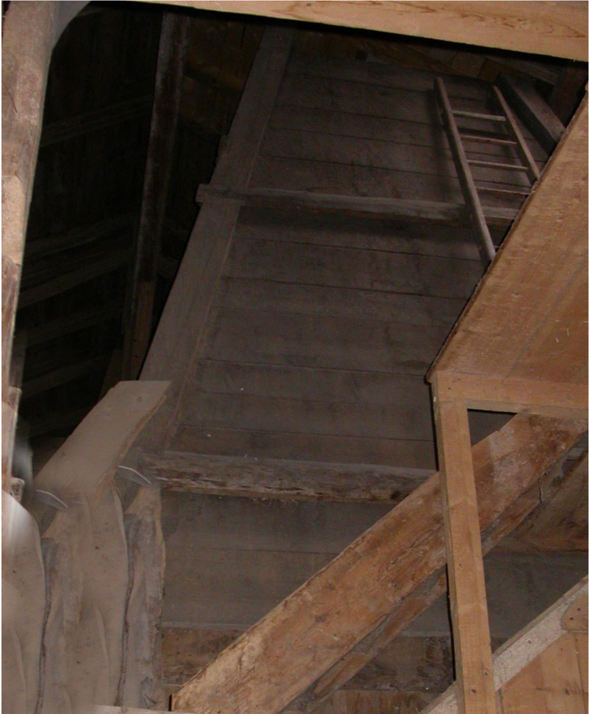
Ferme Meylan de Derrière-la-Côte. La vieille cheminée passe par la grange.
