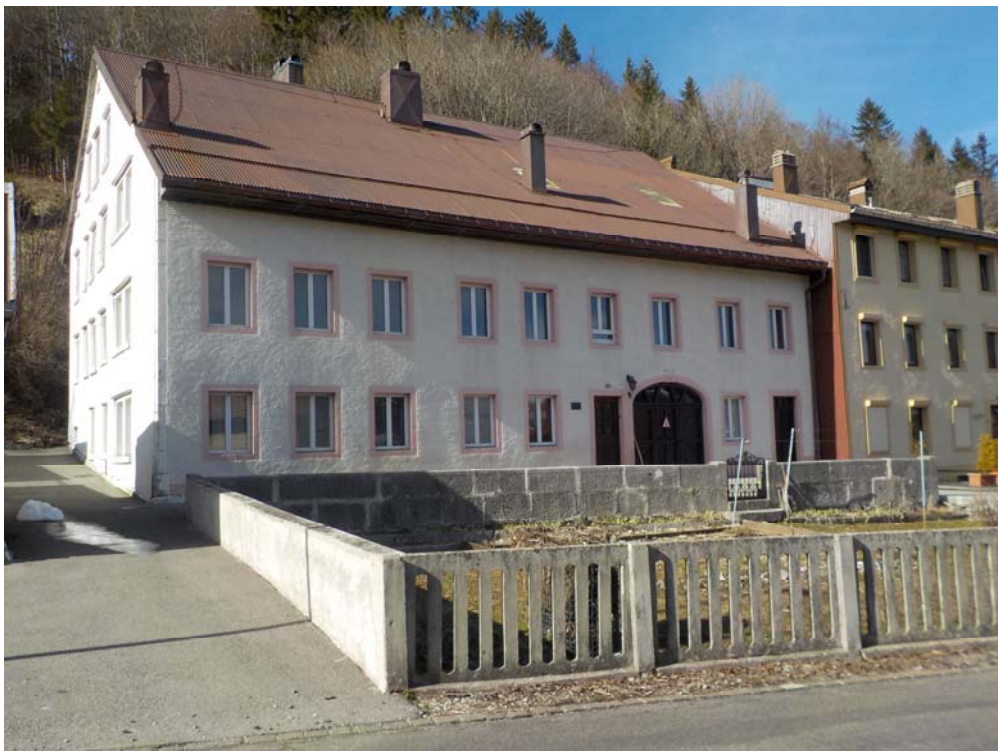
Le grand et beau voisinage de Vers le Lac. Il en a passé des familles Le Coultre, en ces deux bâtiments où les fenêtres sont presque aussi nombreuses que les vagues sur le lac de Joux proche ! On admirera le beau mur séparant la première maison de son jardin.
