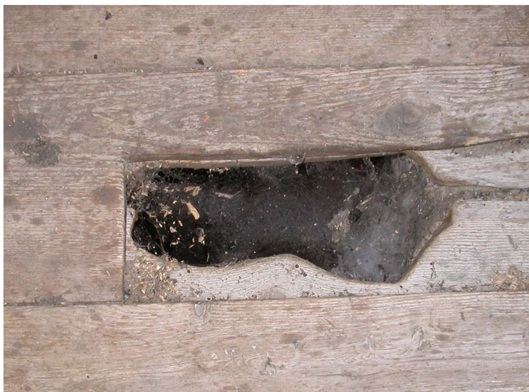
Dans l'un des planchers du clocher, le trou par où passait l'une des deux cordes.
