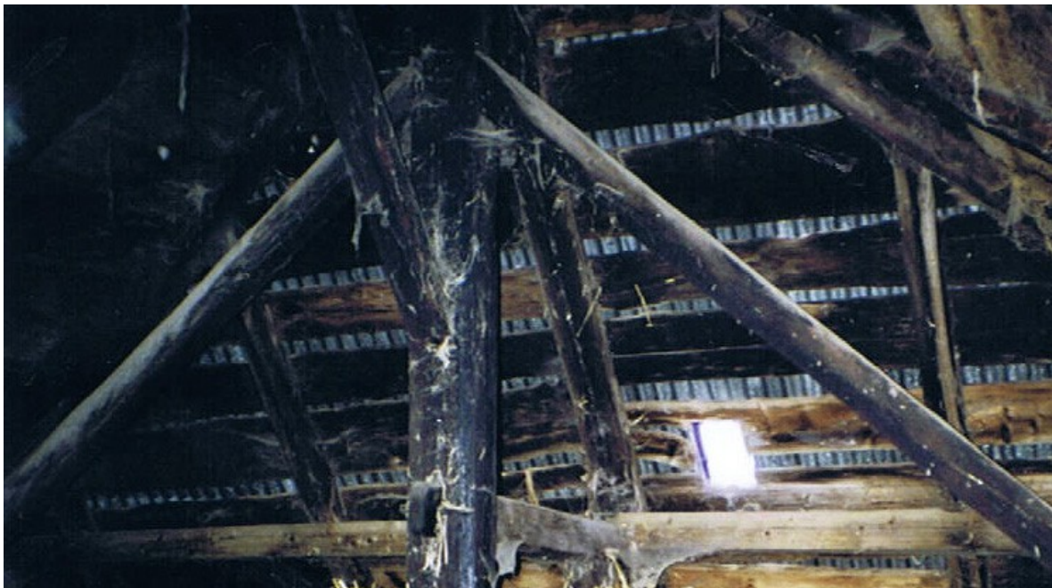
La poutraison du chalet du Crêt-à-Chatron Vieux.
