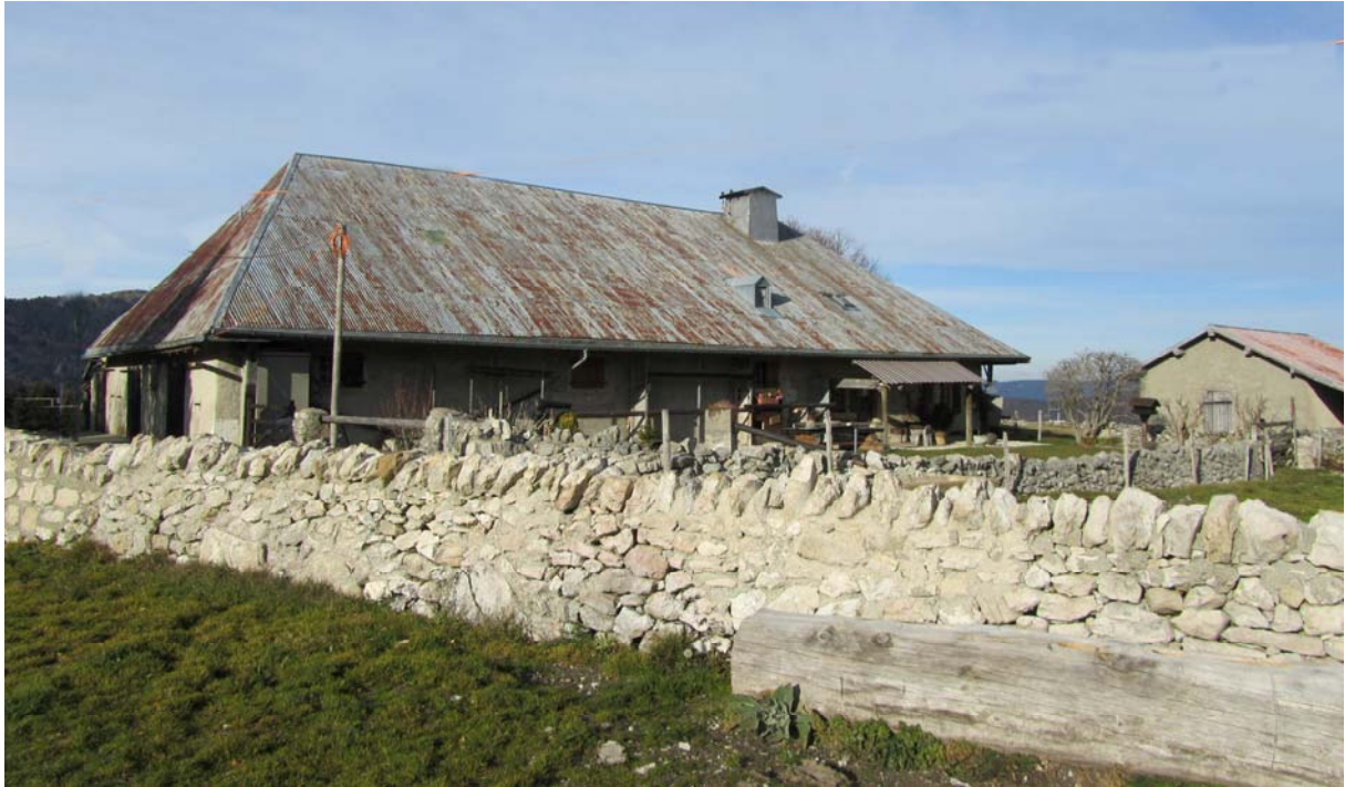
Le Pré de Joux, avec le même grand et beau toit qu'autrefois que l'on a simplement recouvert de tôles ondulées, pratique courante sur nos pâturages du Jura.
