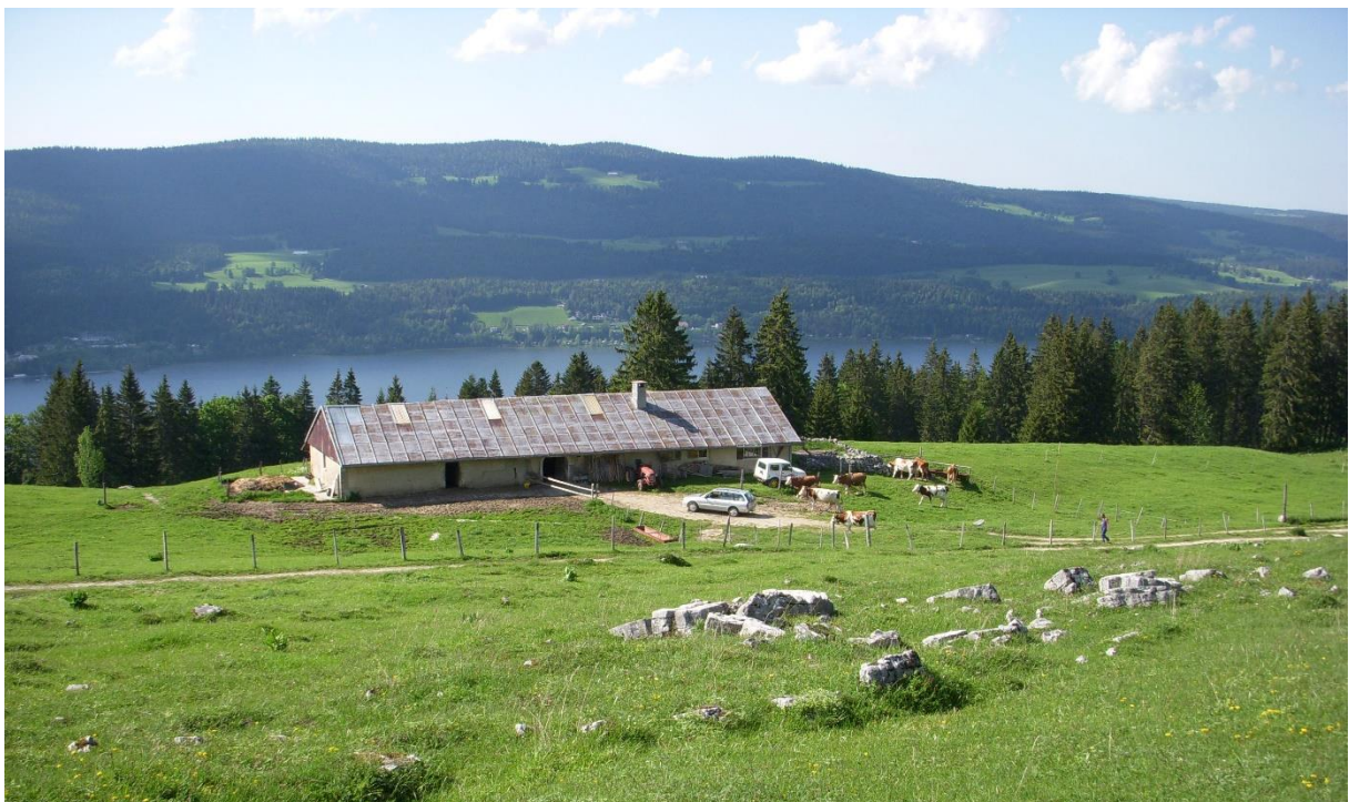
La Branette, joli chalet d'alpage au-dessus des Bioux, de forme rectangulaire avec toit à deux pans.
