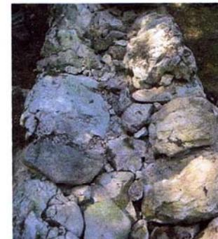
Figure 3 : Maçonnerie intérieure avec les pierres inclinées et très peu de petites pierres entre les parements.
