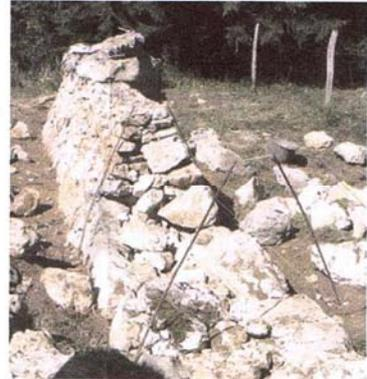
Figure 1 : Utilisation de gabarits sur un chantier.
