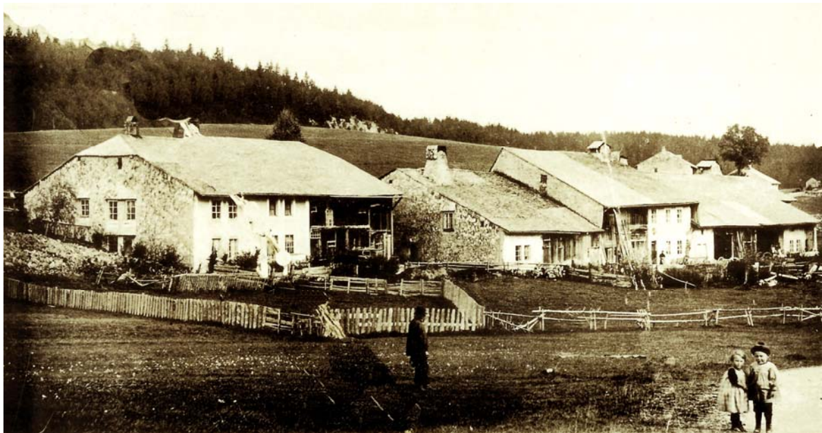
Combenoire au début du XXe siècle. La plupart des maisons ont subi des modifications depuis l'enquête de 1837, notamment celle de gauche et celle du milieu du voisinage.
