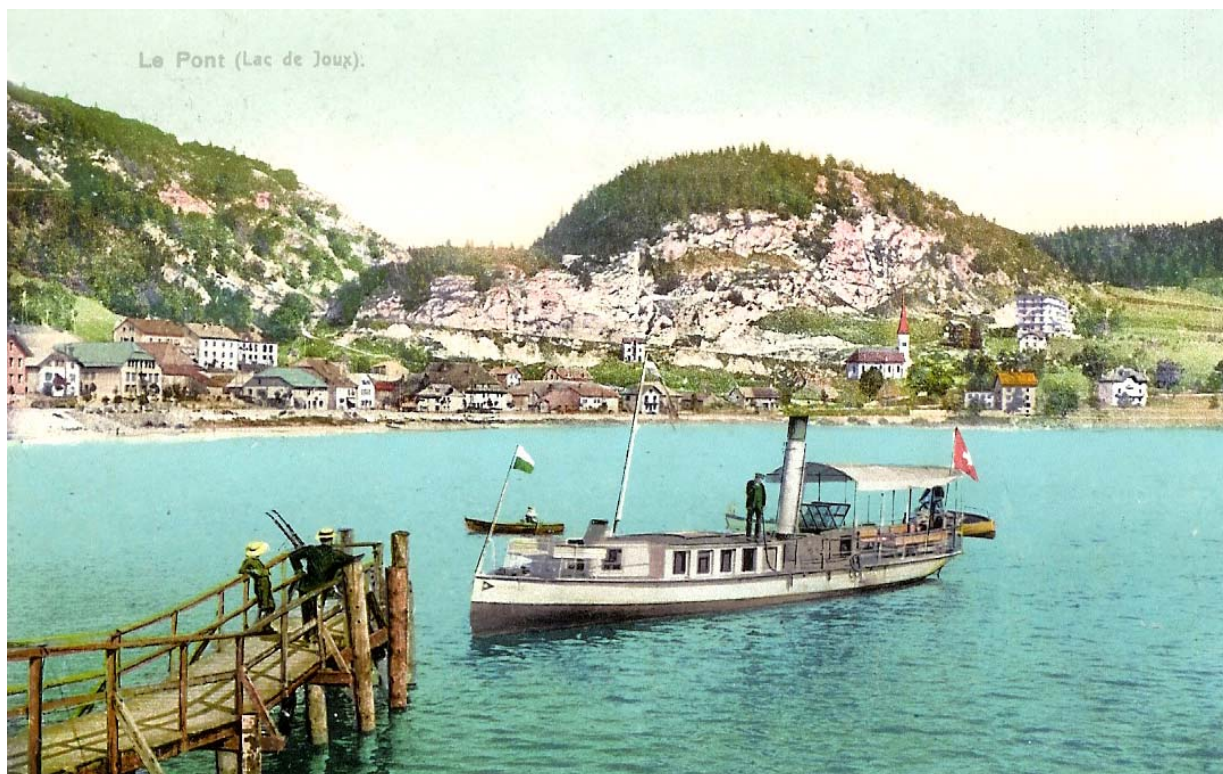
La route balafre de travers la colline de l'Aouille.
