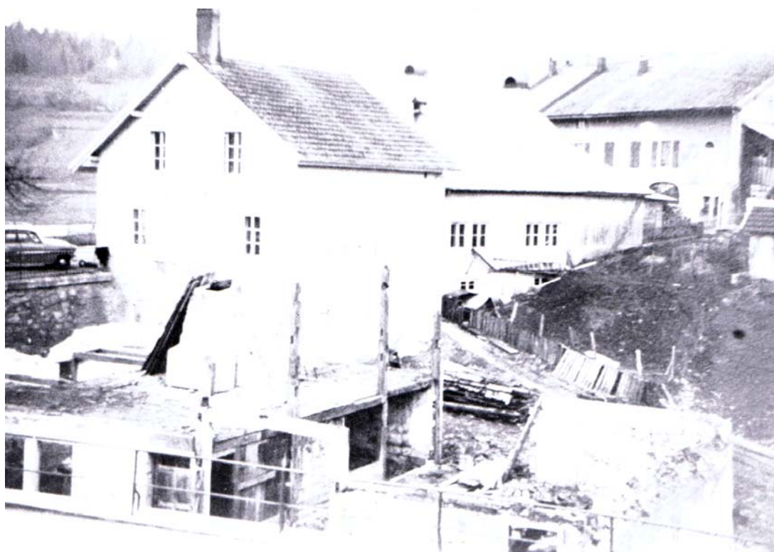
Démolition du vieux moulin.
