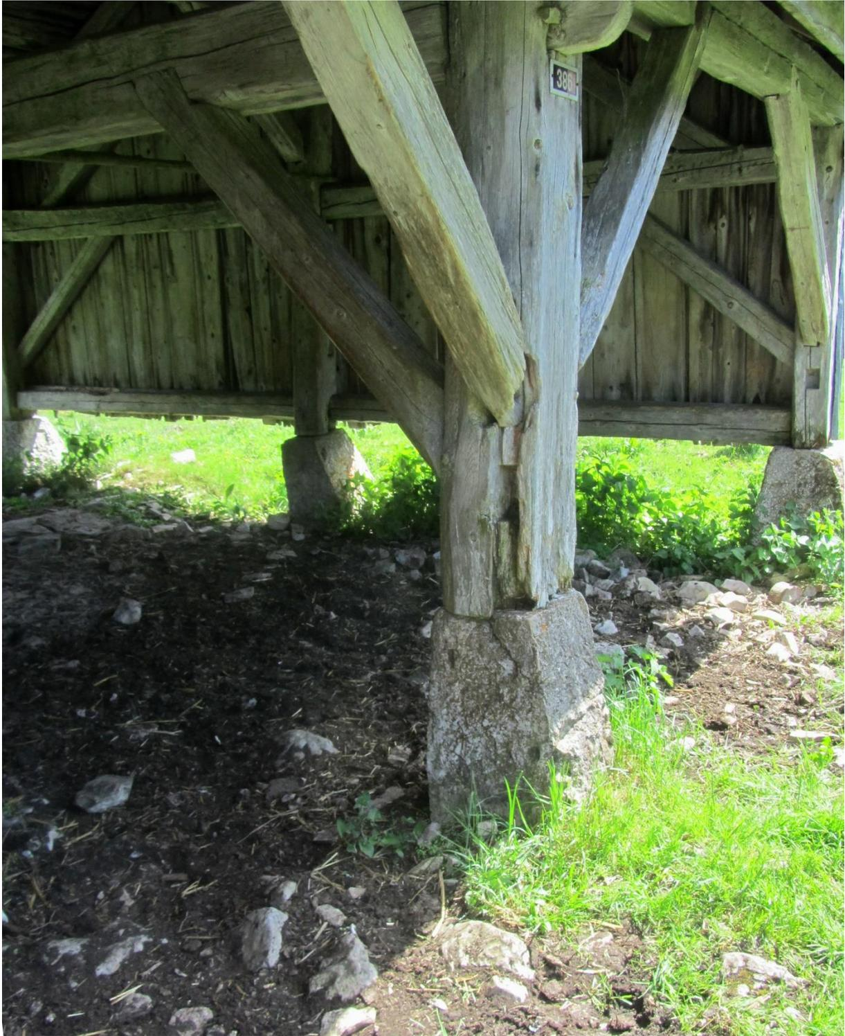
Les piliers reposent sur de solides pierres de forme pyramidale. La base de ces piliers est malheureusement fortement détériorée.
