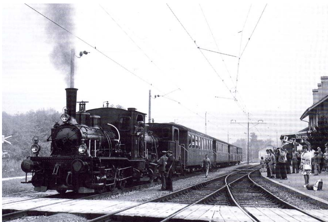
Gare du Pont en 1974, lors du 75 e anniversaire de la ligne Pbr.
