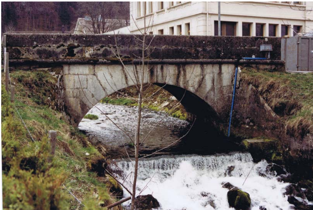
Vu par-dessous. Au-delà l'ancienne fabrique de limes. Photos de 1990 environ.
