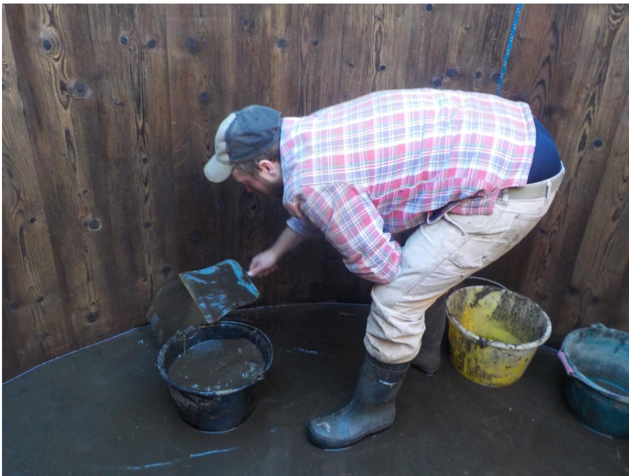
La boue du fond est à enlever jusqu'à la dernière pelletée.
