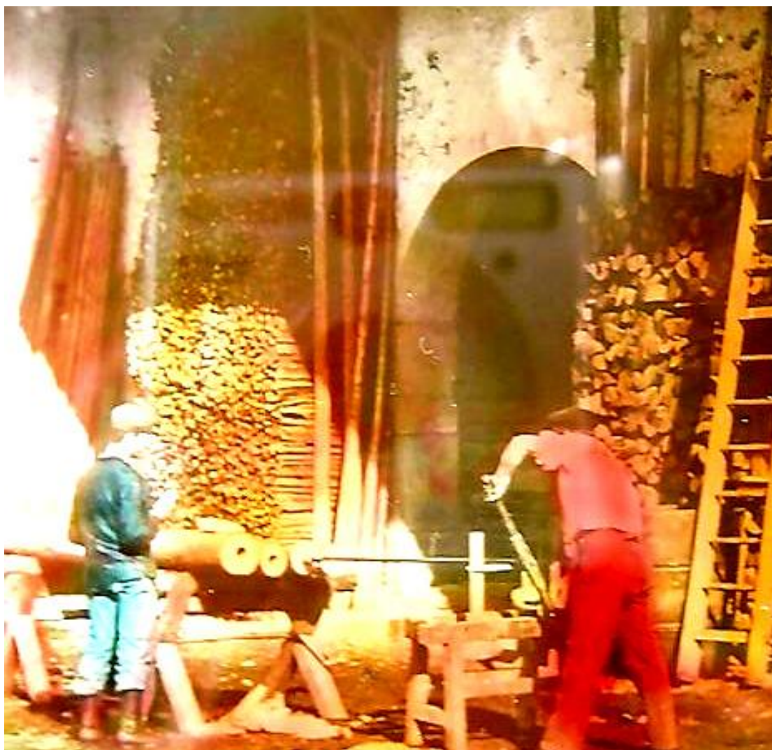
Perçage d'un tuyau au moyen de la longue tarière. Nous sommes à Mouthe et c'est la seule photo de l'époque (vers 1920), que nous possédions en couleur. Sans doute une diapositive.
