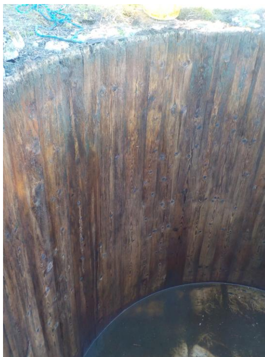
Citerne vieille de plus d'un siècle et pourtant pourtour impeccable.
