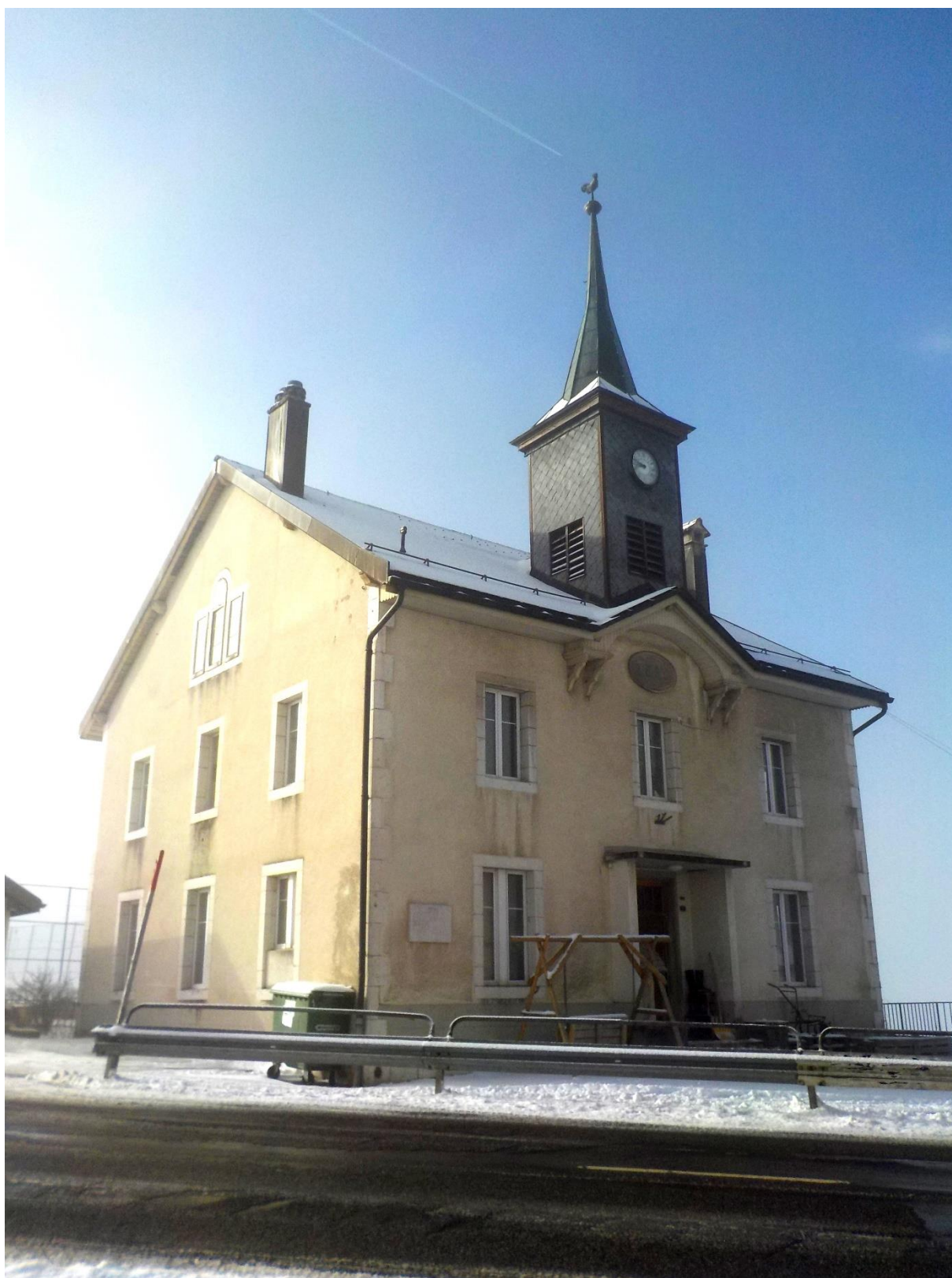
Collège construit en 1880.
