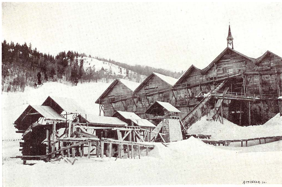
Bâtiments de l'exploitation de la glace.
