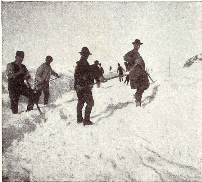
En hiver. Le déblaiement de la route entre le Sentier et le Lieu.
