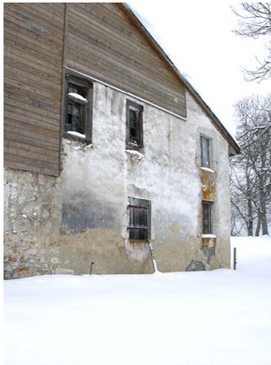
Façade à bise.
