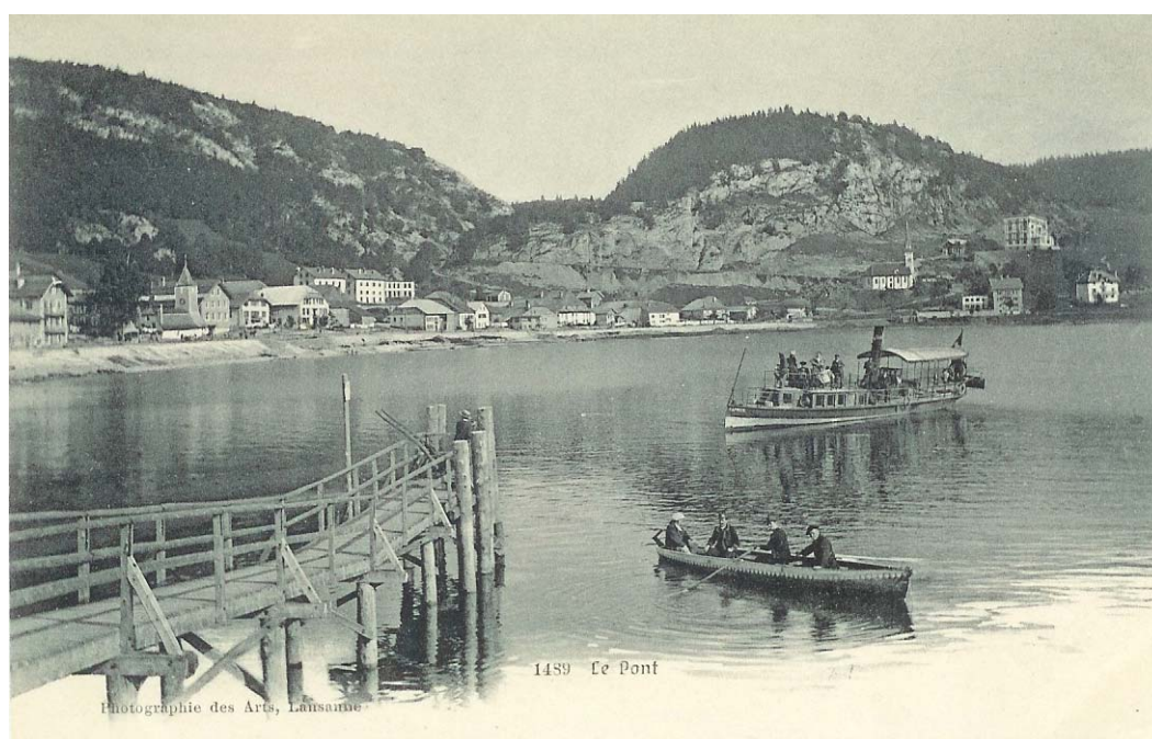
Navigation générale et canotage font bon ménage au Pont. Il est étonnant de constater que les travaux des quais n'offrent pratiquement jamais un chantier grandiose. Tout cela semble même s'être fait dans une certaine discrétion.
