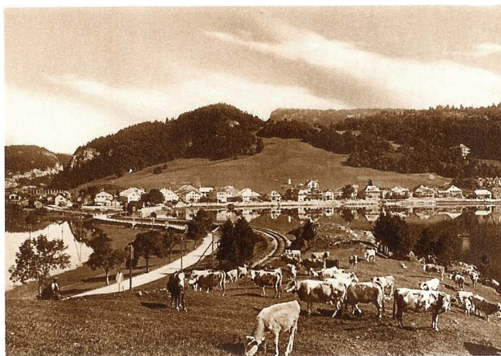
Le Pont, vue générale
