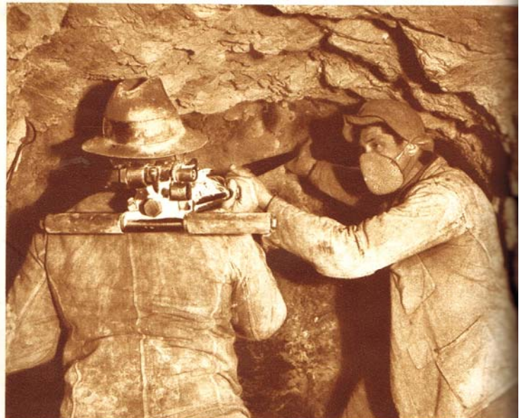
La perforatrice mord le rocher que la dynamite fera sauter. Pour se protéger de la poussière de fer, les mineurs utilisent des masques primitifs devant la bouche et le nez.
