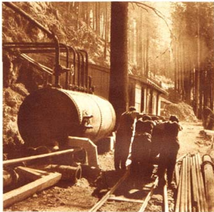
Sur le chantier des mines, dans une forêt de sapins. A gauche, le compresseur à air qui fait fonctionner les marteaux pneumatiques.
