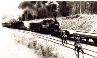
Pour protéger les convois. A la suite des coups de mains des partisans contre les voies ferrées, des précautions sont prises par le Reich pour protéger ses convois. Devant chaque locomotive des trains de ravitaillement, se trouvent deux wagons chargés de sable et de pierres, dont le rôle est de faire sauter les mines éventuelles.
