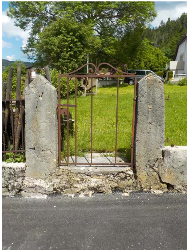
Une entrée qui n'a pas changé en l'espace de cent ans !
