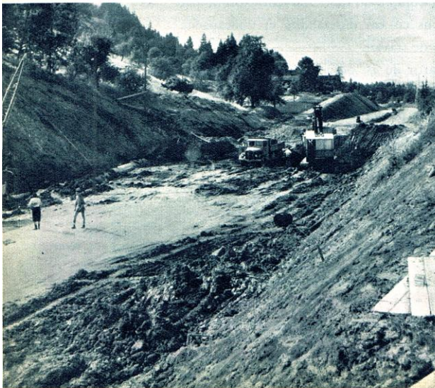
Les différences de niveau sont supprimées par l'arasement de monticules et l'établissement de remblais. Cette image montre quelles masses de terre ont dû être remuées.
