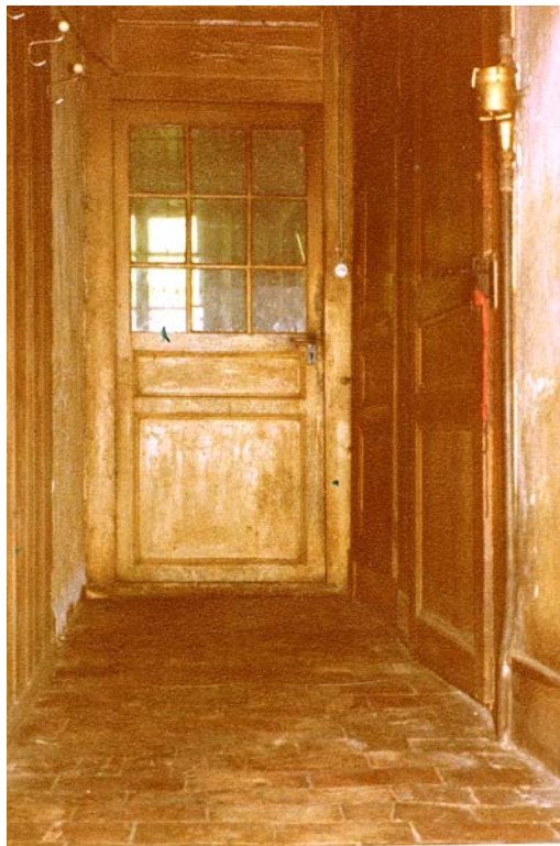
Un corridor traditionnel, avec parois de bois, catelles de terre cuite au sol, et porte du fond. Une autre porte, latérale, doit donne sur la grange.
