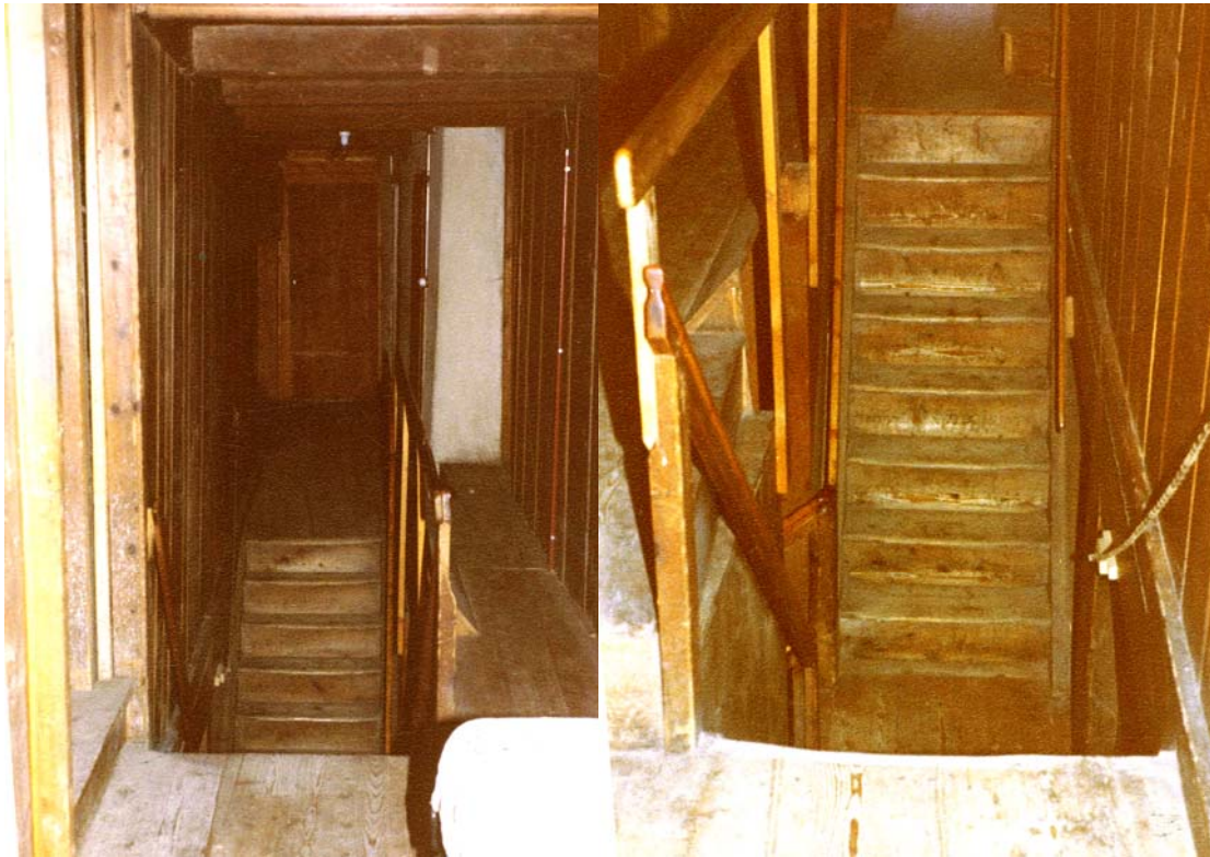
L'accès à l'étage, au niveau de l'appartement, se fait curieusement par une double rangée d'escaliers.
