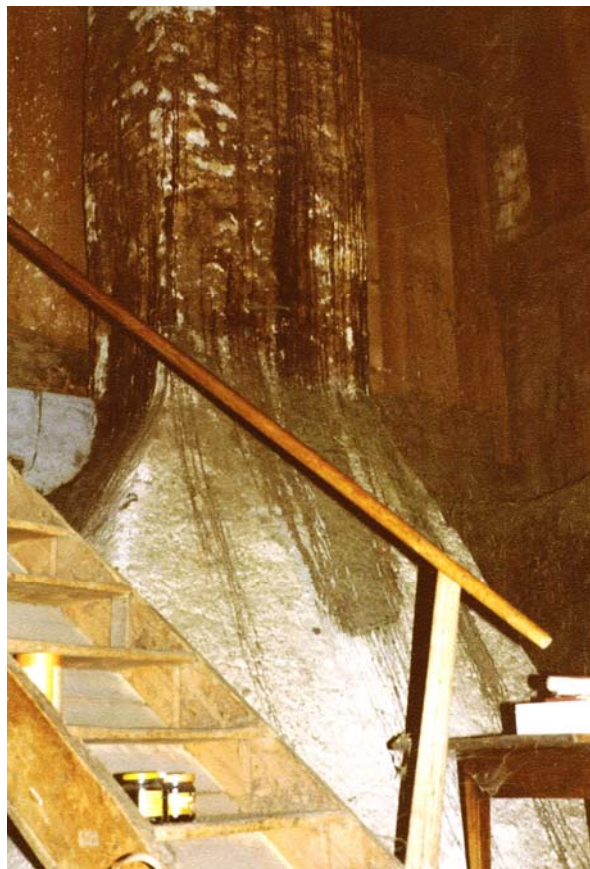
Dans les combles, une échelle, de biais, conduit à des niveaux supérieurs. Vision de l'énorme cheminée, en dur depuis des époques que l'on ignore.
