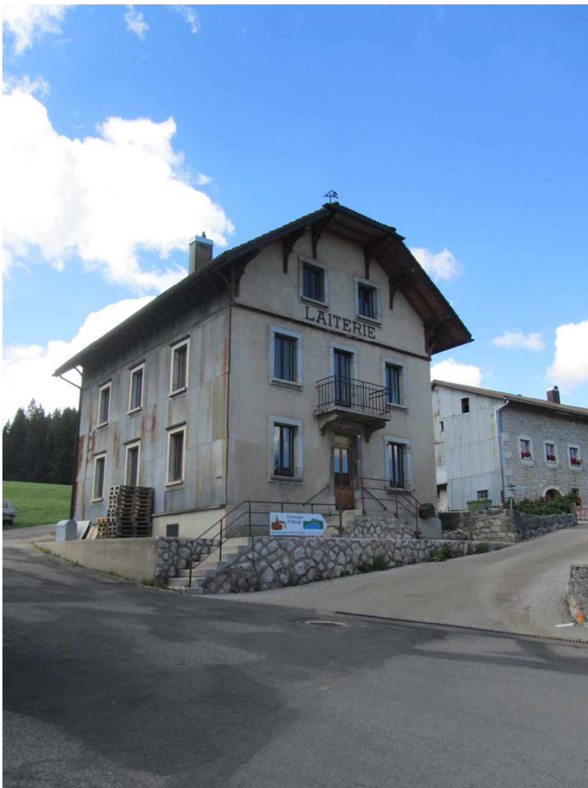
Le deuxième bâtiment de fromagerie du Solliat tel qu'il se présente encore aujourd'hui. L'histoire de la Société pendant toute la durée de l'utilisation de ces locaux reste à faire.
