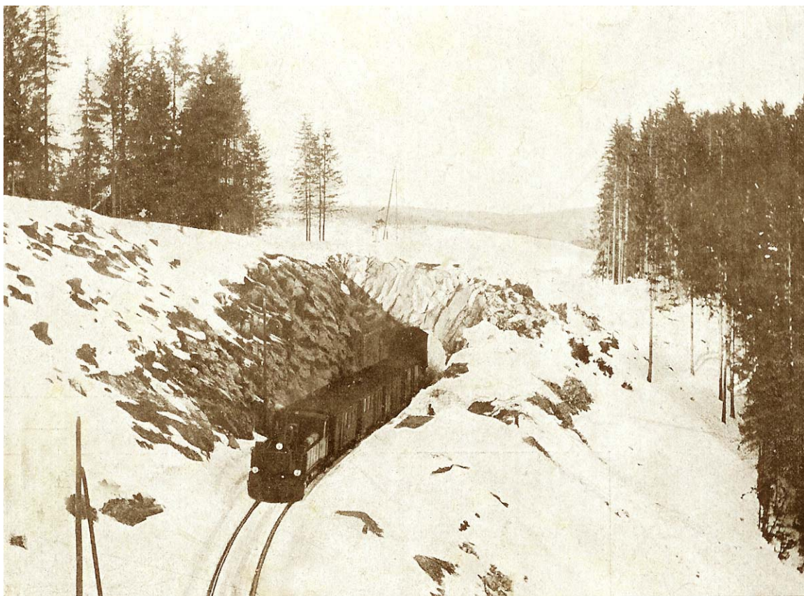
937. — Sortie du tunnel près Le Pont
