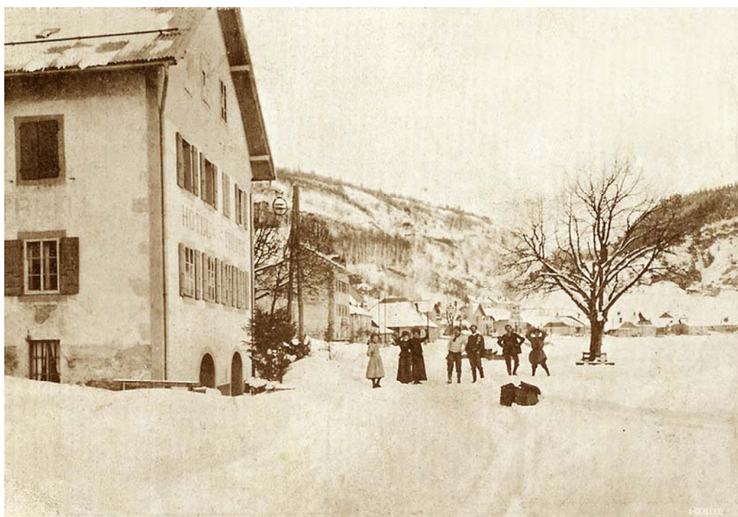
920. — Le Pont et l'Hôtel de la Truite. Entrée du hameau
