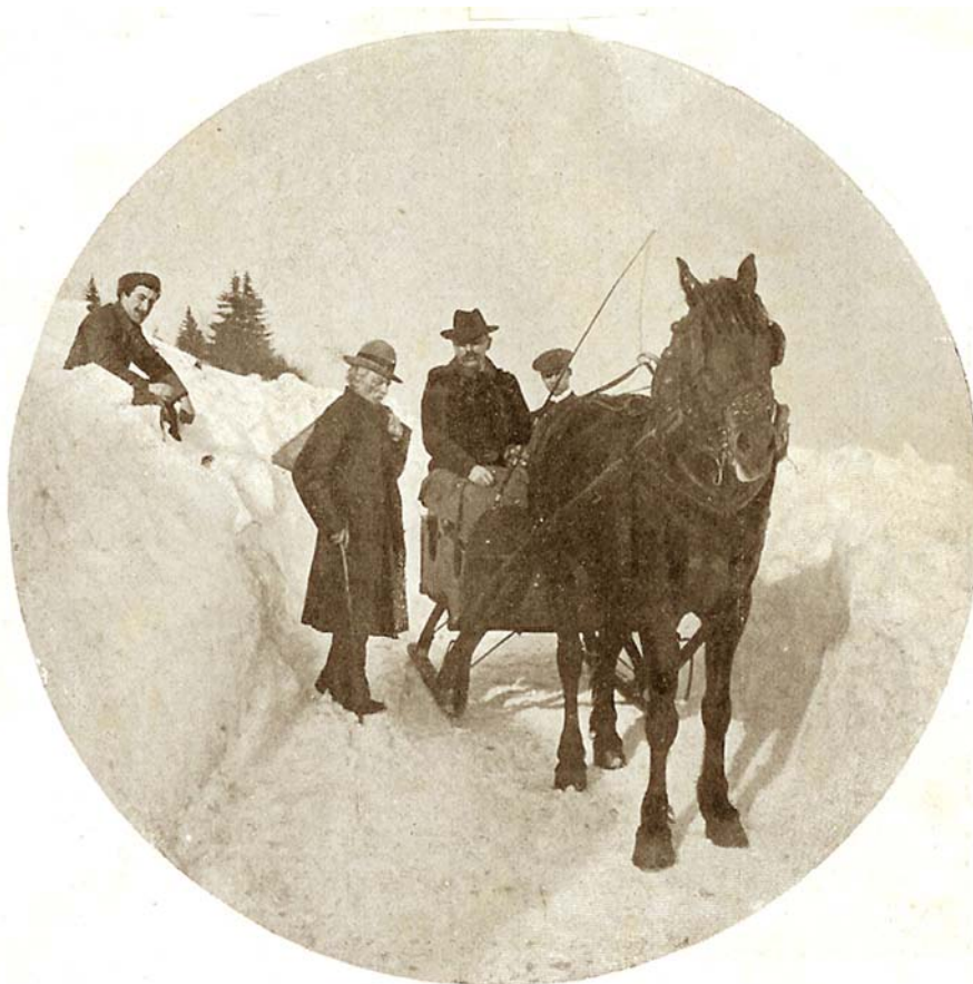
919. — Une tranchée dans la neige
