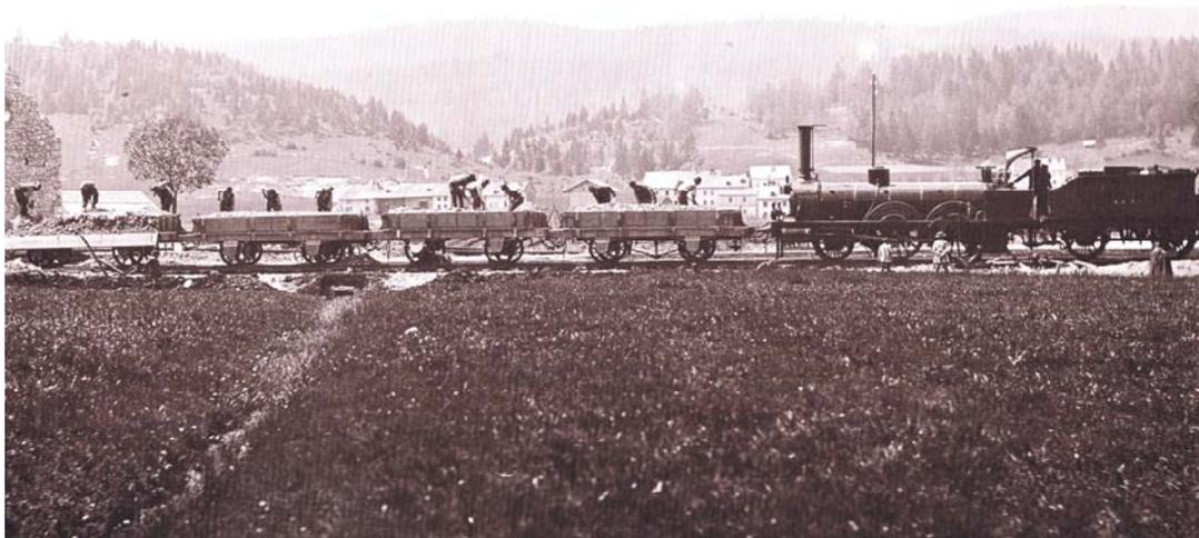
Construction de la ligne entre le Sentier et le Brassus avec l'aide d'un décauville. On pose le ballast. Photo Auguste Reymond
