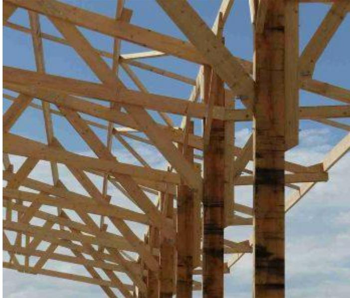
La charpente est un assemblage d'éléments structurels qui constituent le squelette d'une toiture. Il s'agit d'une ossature porteuse et de contreventement. La **charpente** peut être constituée de différentes pièces de bois, de poutrelles, de béton et de profilés de métal. Une bonne charpente garantit la stabilité et l'intégrité de la structure porteuse d'une toiture, pour de longues années.
