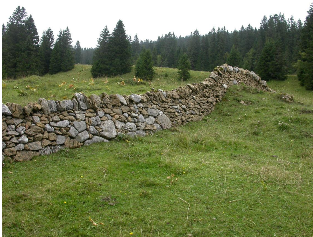
Mur restauré de la région des Amburnex. Le brun des pierres lui offre une esthétique tout à fait remarquable.
