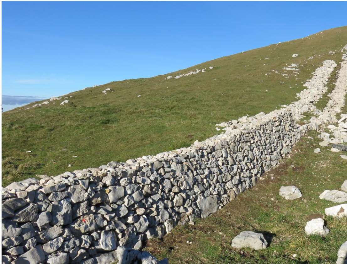
Au sommet du Mont-Tendre, mur en construction en octobre 2015.
