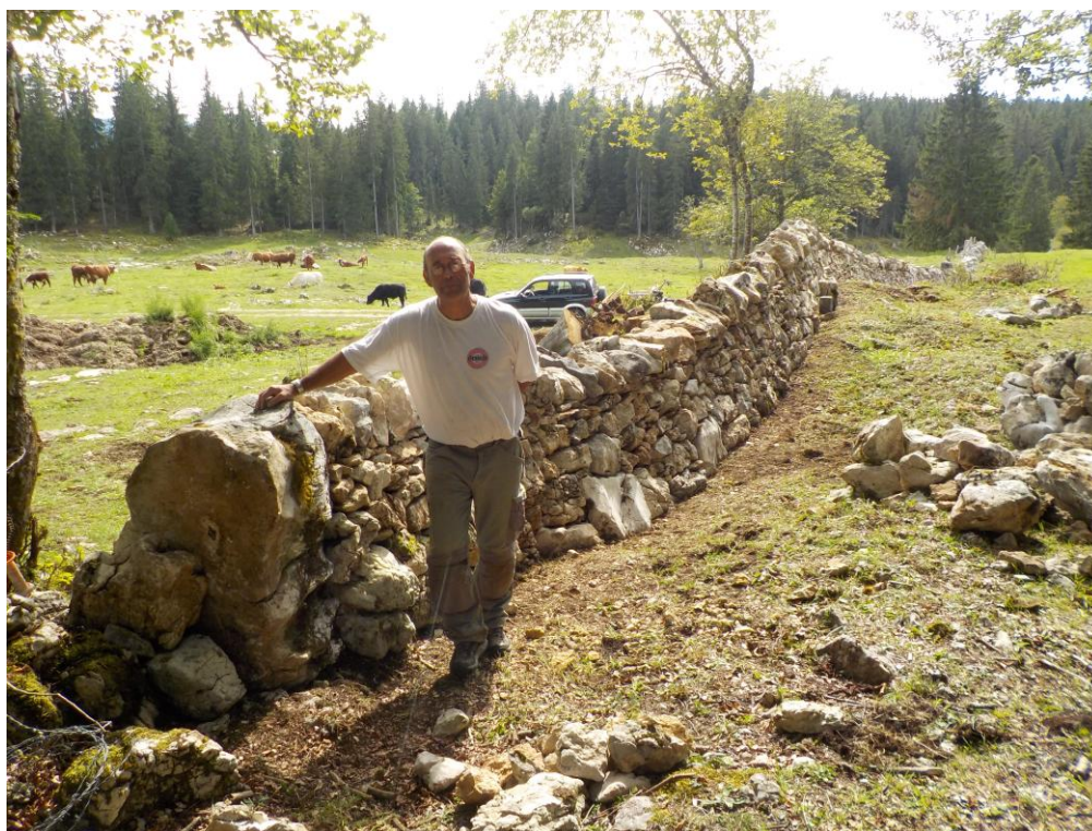
Le muretier Eric Jeannot de Bois-d'Amont. Pour le charriage des pierres, un simple tracasset. Première partie, au-dessus du chemin, achevée. Beau boulot, l'ami !
