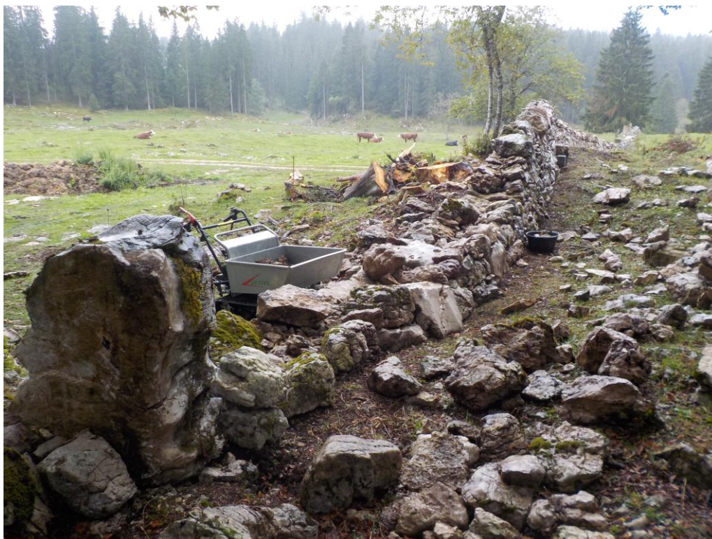
Les débuts des travaux en automne 2019.
