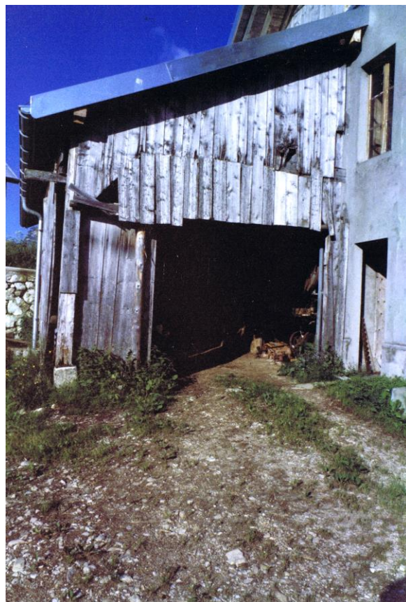
Une remise qui ne paie pas de mine.
